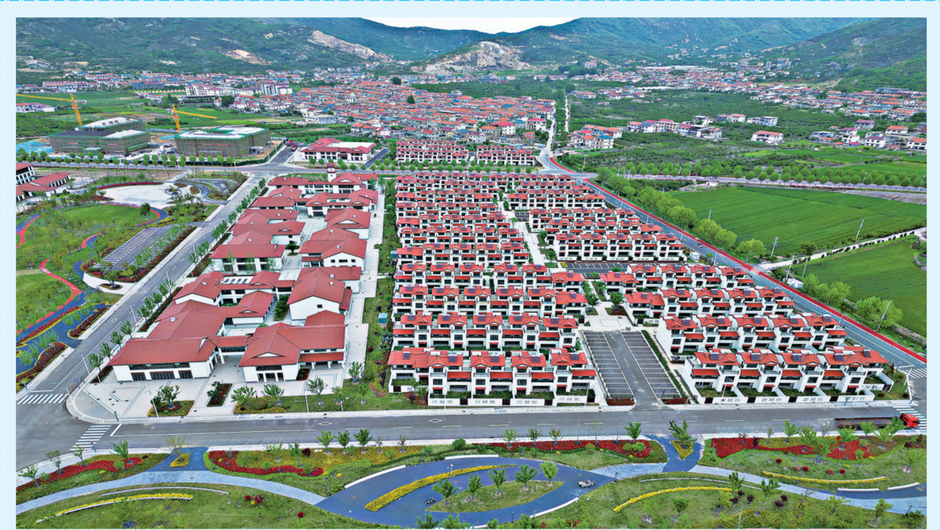
4月28日,由建安公司承建的云台街道樱桃谷新型农村社区一期工程一标段项目顺利通过竣工验收。工程总建筑面积约8万平方米,主要包括60幢居民楼、社区党群服务中心、公园、幼儿园、文创商业区等工程项目。
