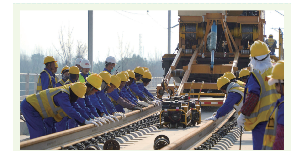
1月16日上午10点18分,首对500米长钢轨被铺轨机平稳地铺设在无砟轨道板上,标志着宣绩高铁全线开始铺轨。
