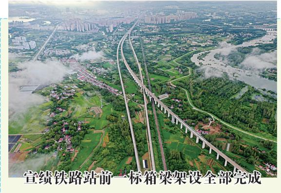
8月23日凌晨3点,由宣绩项目部、丰桥公司承建的宣绩铁路674孔箱梁架设任务全部完成,为后续无 砟道床施工和铺轨作业奠定了坚实基础。该项目单线梁160孔,双线梁514孔,采用"场内预制,架桥机封 锁点内架设"方式施工。
