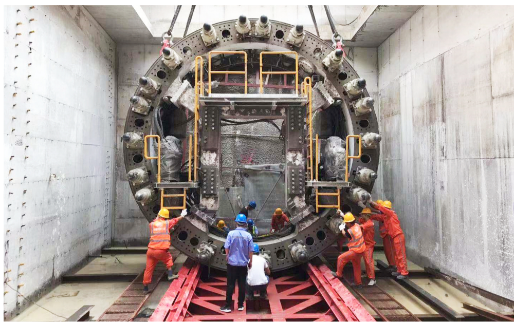
▲“黔进号”盾构机下井组装
