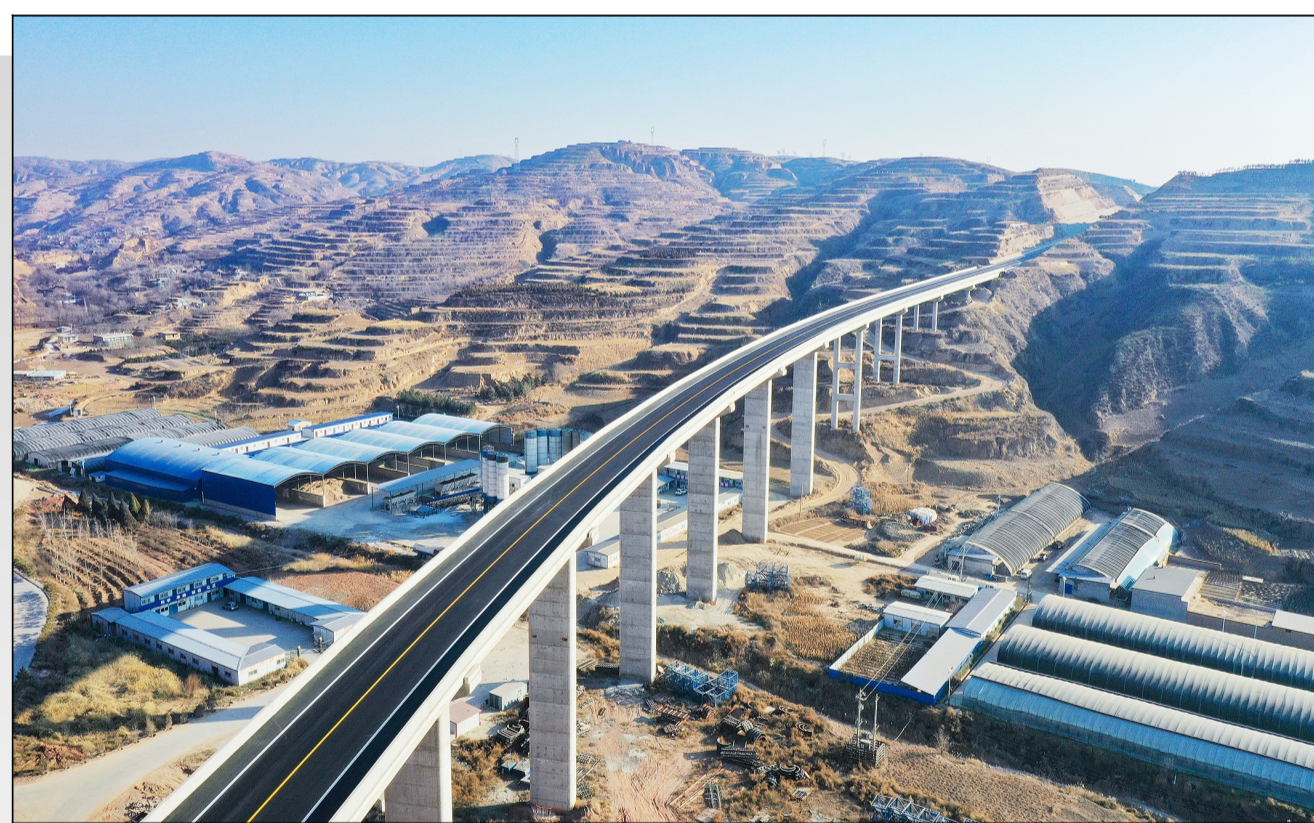
2021年12月29日,太原公司承建的吕梁市兴县北山过境公路全线贯通。
