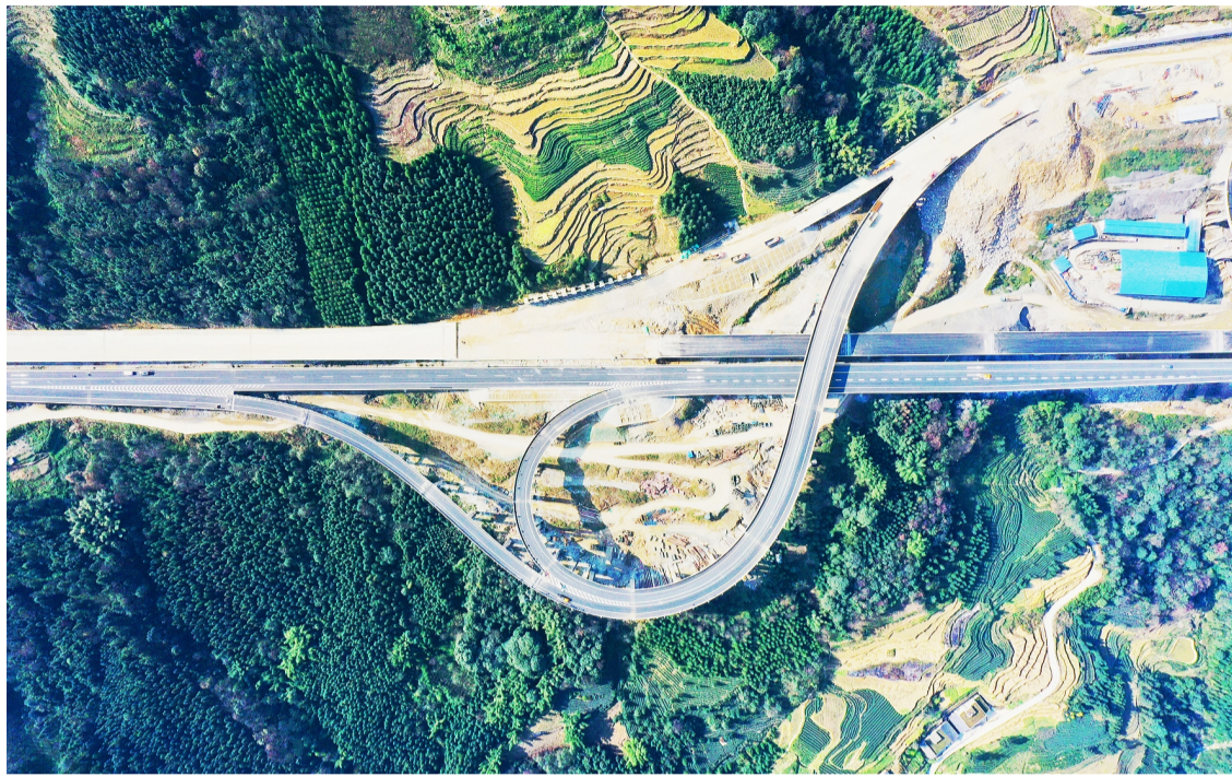
▲宜彝高速公路(四川段)西部洞群互通
