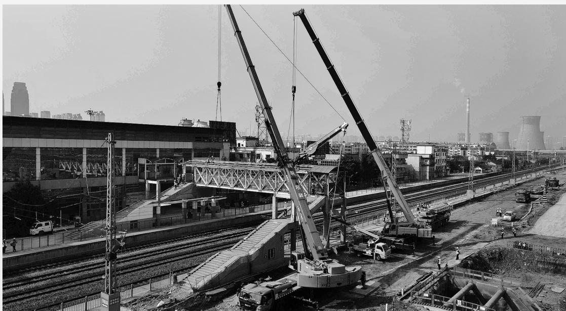
10月22日,路桥公司承建的宿州火车站钢结构人行天桥拆除。该桥上跨京沪线,总长40米,整体重达28.9吨。施工中,项目部细化施工方案,优化作业工序,在确保营业线正常开通的前提下
