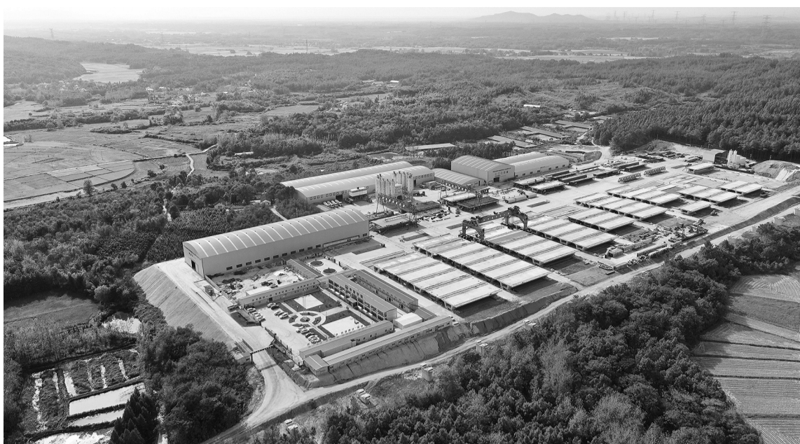
▲丰桥公司宣城铁路项目开展架场标准化生产
