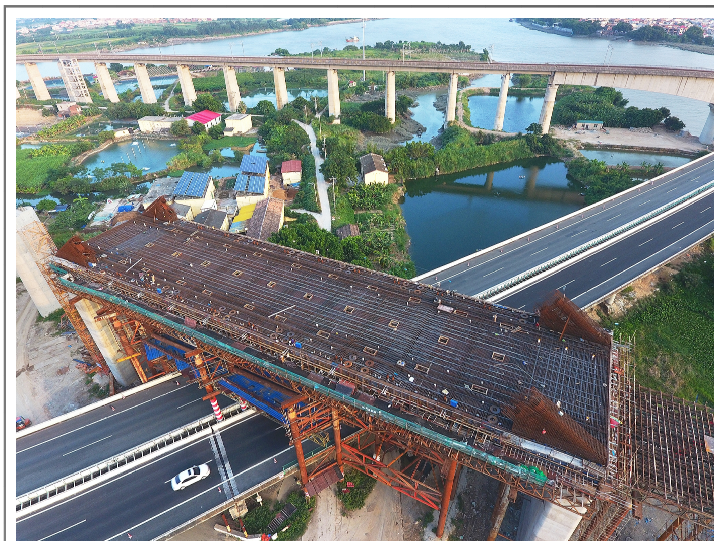
9月26日,路桥公司承建的福厦高铁重点控制性工程——九龙江特大桥漳州段拱系梁混凝土浇筑施工完成。该拱系梁上跨沈海高速,中心线处梁全长75.2米,跨径72米,下承式钢管混凝土系杆拱结构。施工中,两台泵车历时30小时完成1800立方米混凝土浇筑任务。(杨瑞明 柳洋文/摄)
