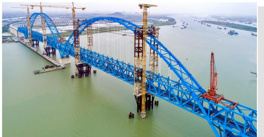
4月24日,随着最后一组吊杆张拉到位,中铁六局承建的南沙港铁路跨洪奇沥水道特大桥主桥完成柔性拱体系转换施工工序,标志着全桥主体结构完工。
