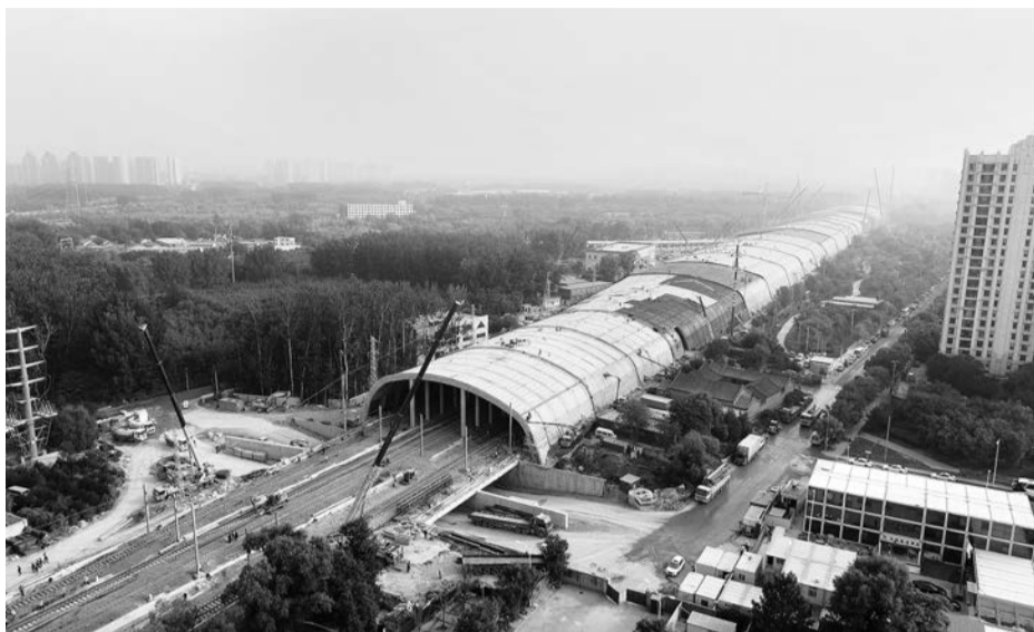
▲京沈客专朝阳枢纽工程全封闭式声屏障施工
